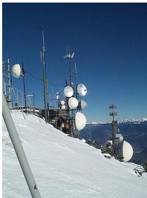
Le strutture di sostegno sono di medie piccole dimensioni e sono distribuite tra il rifugio e la grande torre in cemento armato di TELECOM. Gli impianti sono collocati ad una altezza molto bassa, in un caso addirittura direttamente a terra.
