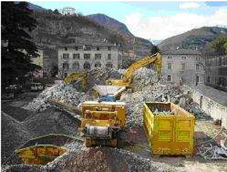
*Fig. 3.13/c - Impianto mobile itinerante*
