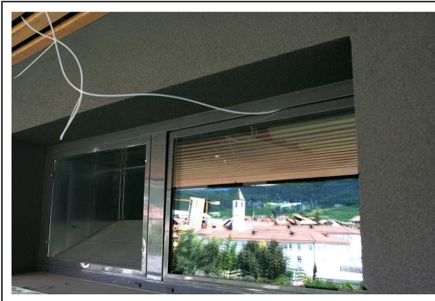
Fig.2.3 Dettaglio del punto di prelievo dell'aria da analizzare con sonda esterna
