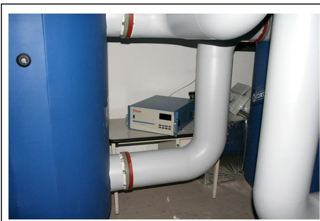
Fig.2.5 Posizionamento interno dell'analizzatore in continuo degli ossidi di azoto
