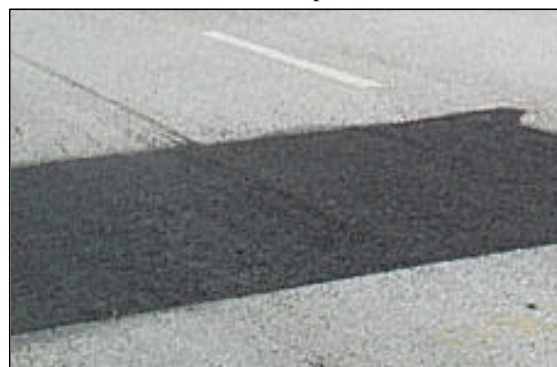
FIGURA 2. Dosso costruito in opera
