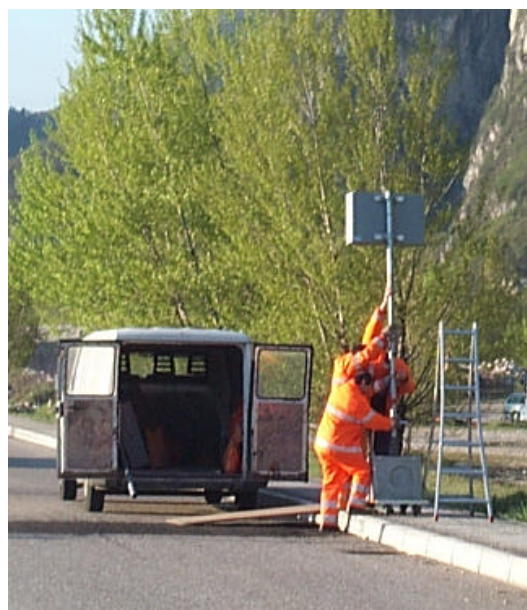
FIGURA 4. Installazione degli apparecchi
