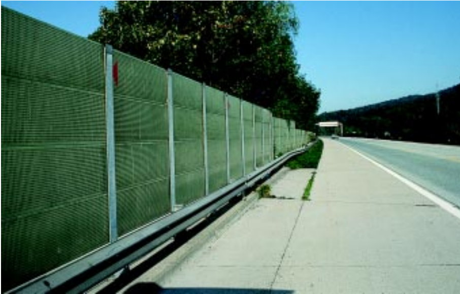
Fig. 10.10 - Esempio di barriera antirumore lungo un tratto stradale
