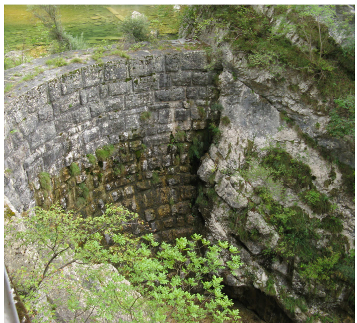
Serra in pietra e cemento sul Torrente Leno di Vallarsa, nella forra di San Colombano.
