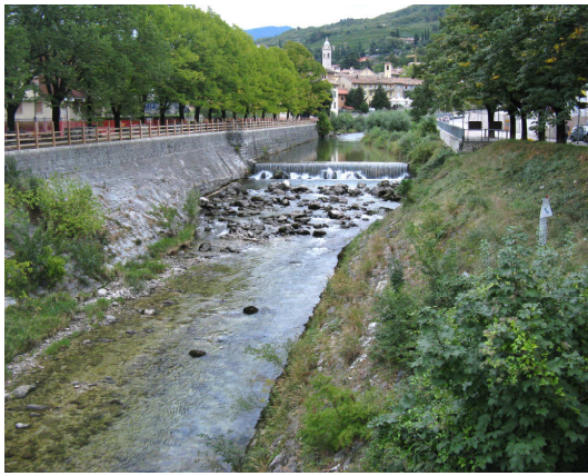
L'alveo del Leno a Rovereto è caratterizzato dalla presenza di alti argini in muratura e di briglie di ritenuta costruiti nel tempo a protezione della città.
