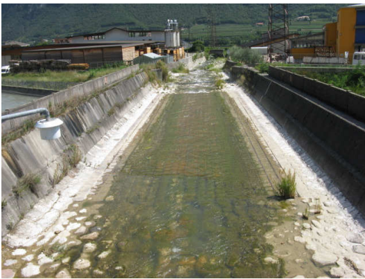
Cunettone sul Torrente Aviana.
