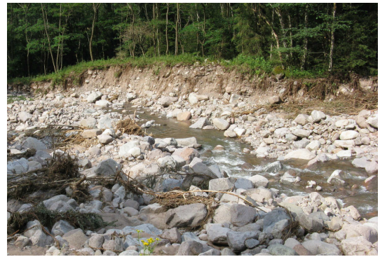
A seguito delle precipitazioni più intense la portata dei corsi d'acqua aumenta anche di dieci volte o più: dopo che la piena è passata, rimane la traccia di una intensa azione erosiva sull'alveo e sulle sponde.
