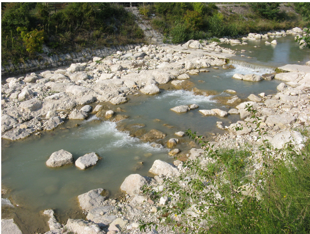
La rampa in massi realizzata su una delle briglie del basso Leno: numerose pozze successive permettono di superare gradualmente il dislivello costituito dalla briglia esistente a monte.
