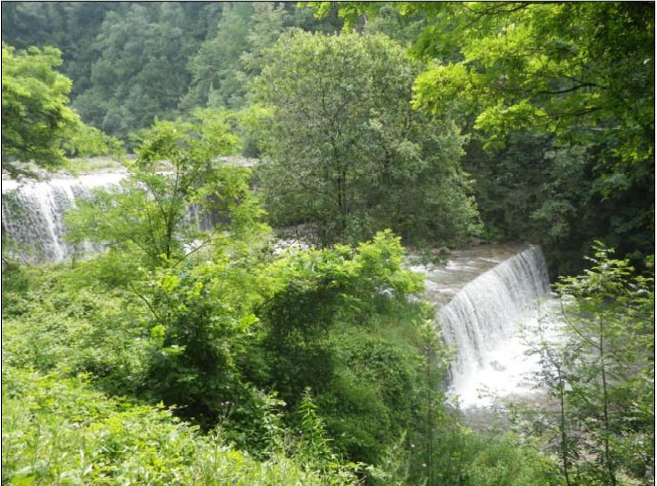
Questo tratto presenta una successione di briglie con distanza/larghezza alveo di morbida < 3:1 che banalizza la morfologia della sezione trasversale, incide negativamente sulla diversificazione degli elementi idromorfologici, rallenta la velocità della corrente (diminuendo il potere erosivo) e costituisce un ostacolo per la fauna ittica che non può risalire il corso d'acqua per i propri fabbisogni migratori, riproduttivi o trofici.
