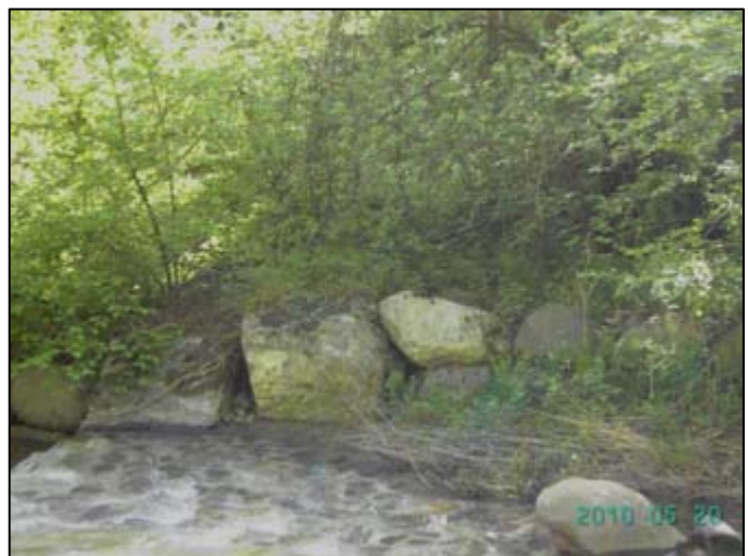
Massi con funzione antierosiva in destra.
