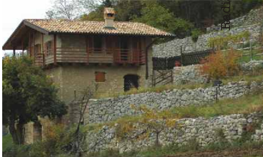
Edifici monitorati con valore medio di radon superiore a 500 Bq/m 3 (D.L. 241/00)
