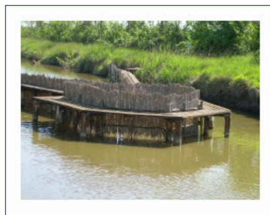
CANALIZZAZIONI PER LA CATTURA DEI PESCI
