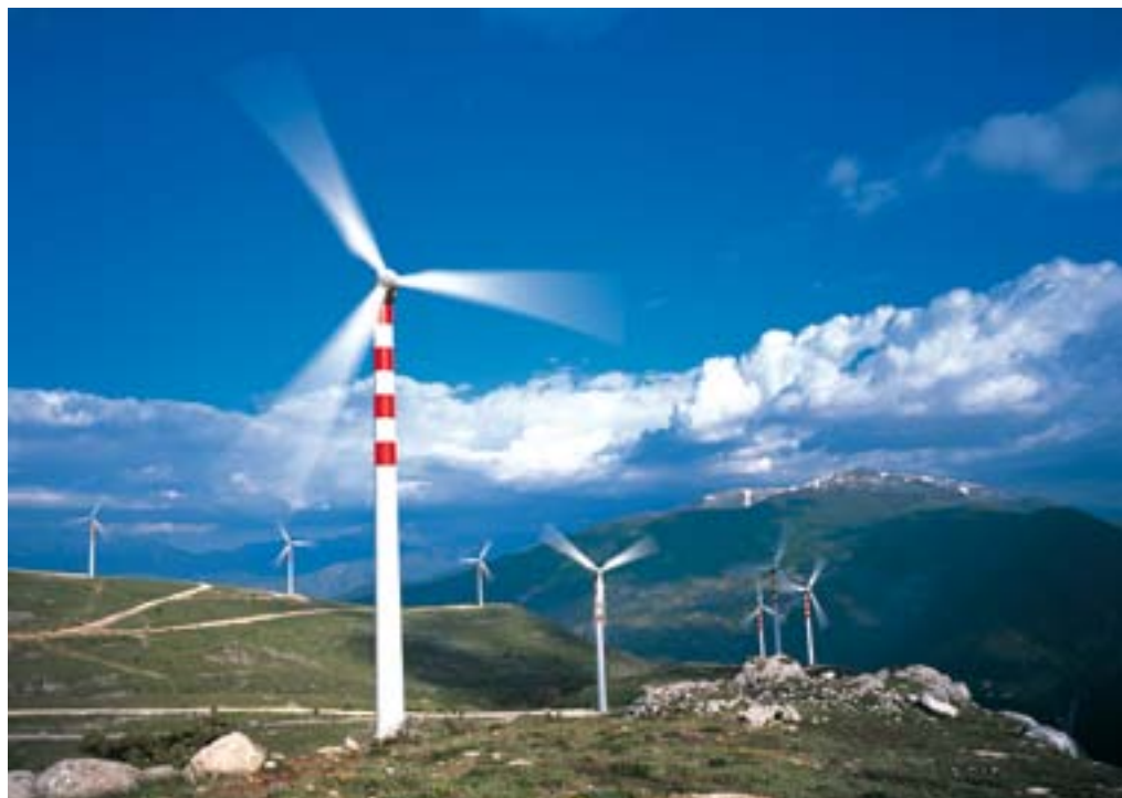
Impianto eolico Comune di Cocullo (AQ)
