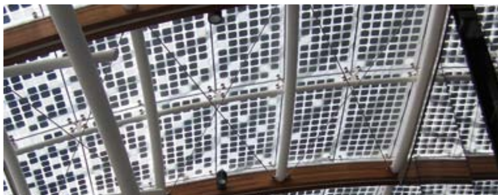
Impianto fotovoltaico integrato nella copertura, piazza Porta Nuova, Comune di Milano
