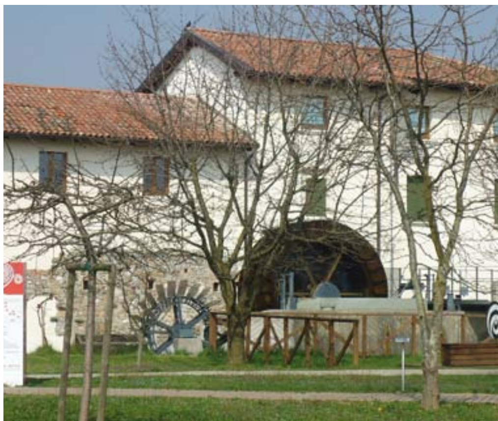
Impianto idroelettrico su ex mulino, Comune di Tavagnacco (UD)
