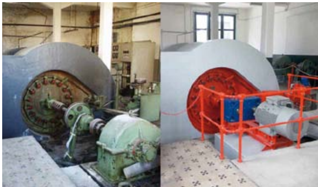
Revamping impinato idroelettrico, Comune di Nembro (BG)
