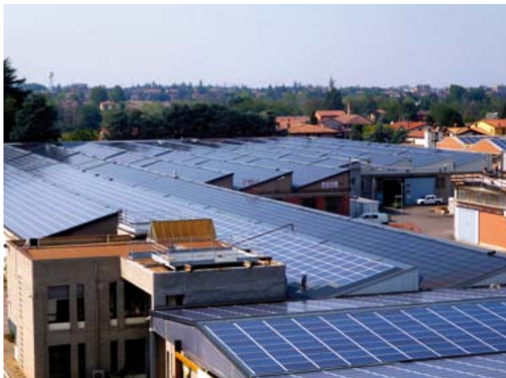
Impianti fotovoltaici, Comune di Castelvetro (MO)
