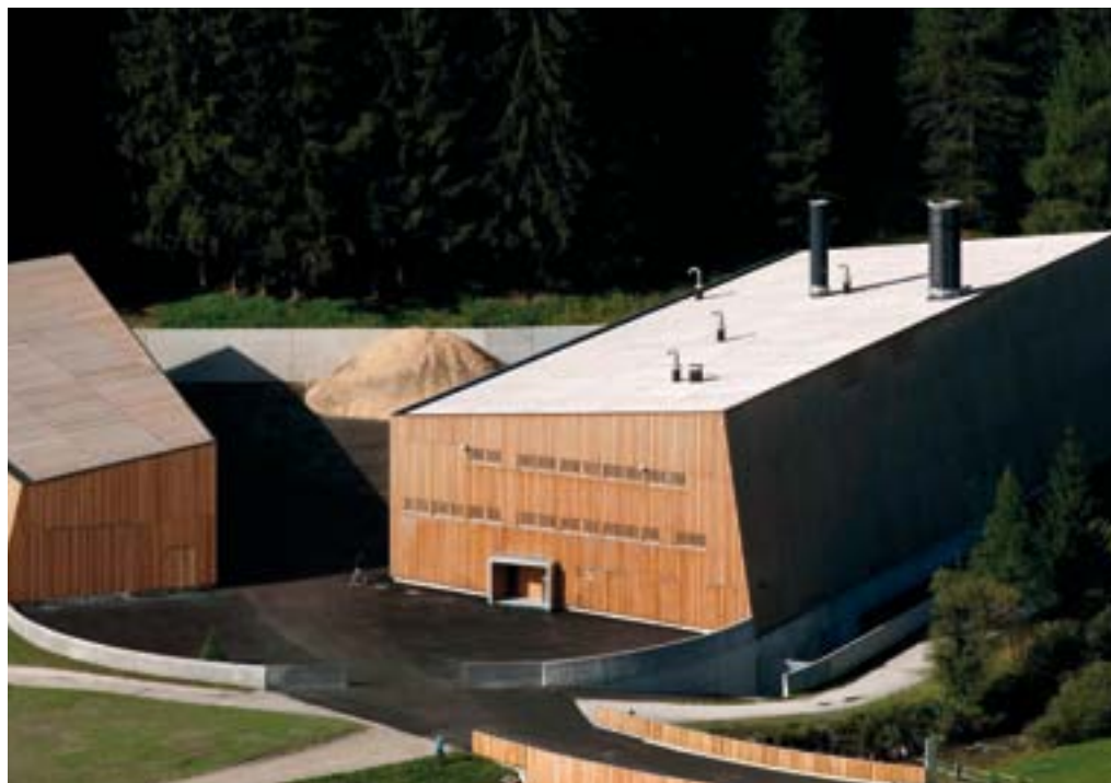
Impianto di teleriscaldamento nel Comune di Sesto (BZ)
