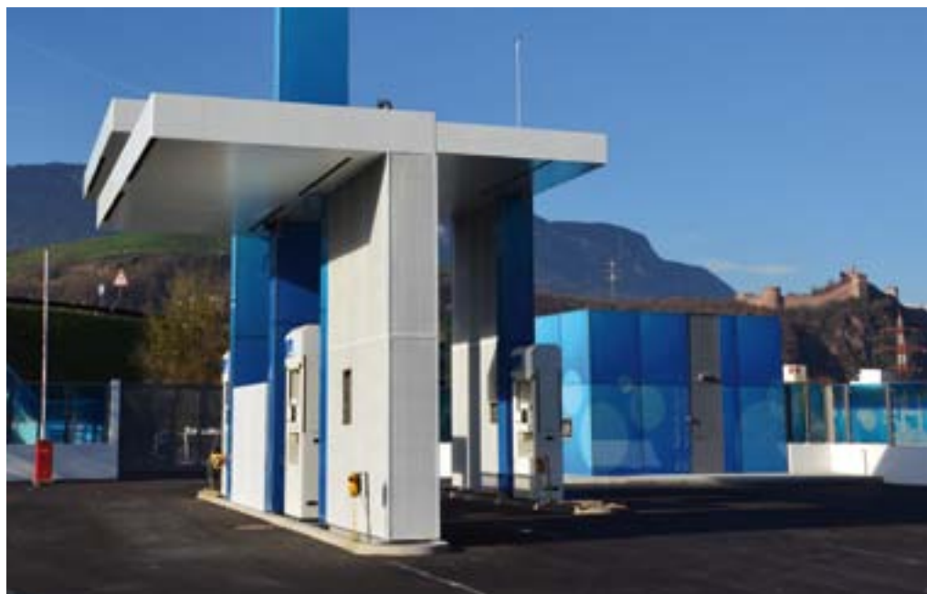
Distributore a idrogeno, Comune di Bolzano
