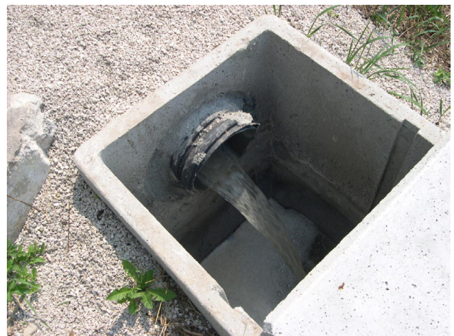
Foto: particolare di un pozzetto idoneo al controllo
