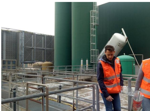
Figura 1: sommità delle vasche di depurazione acque
