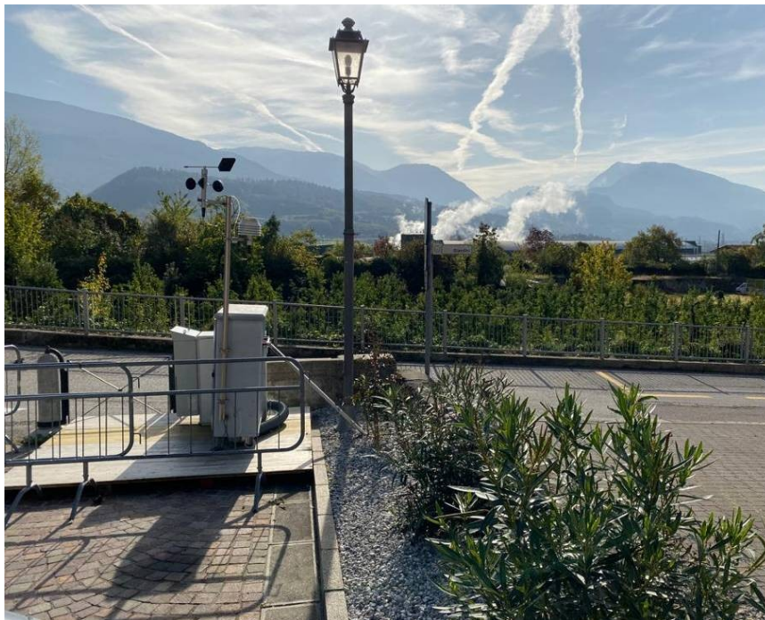
Figura 4: posizionamento strumentazione all'incrocio tra le vie Giardini e Oriola in località Pradi
