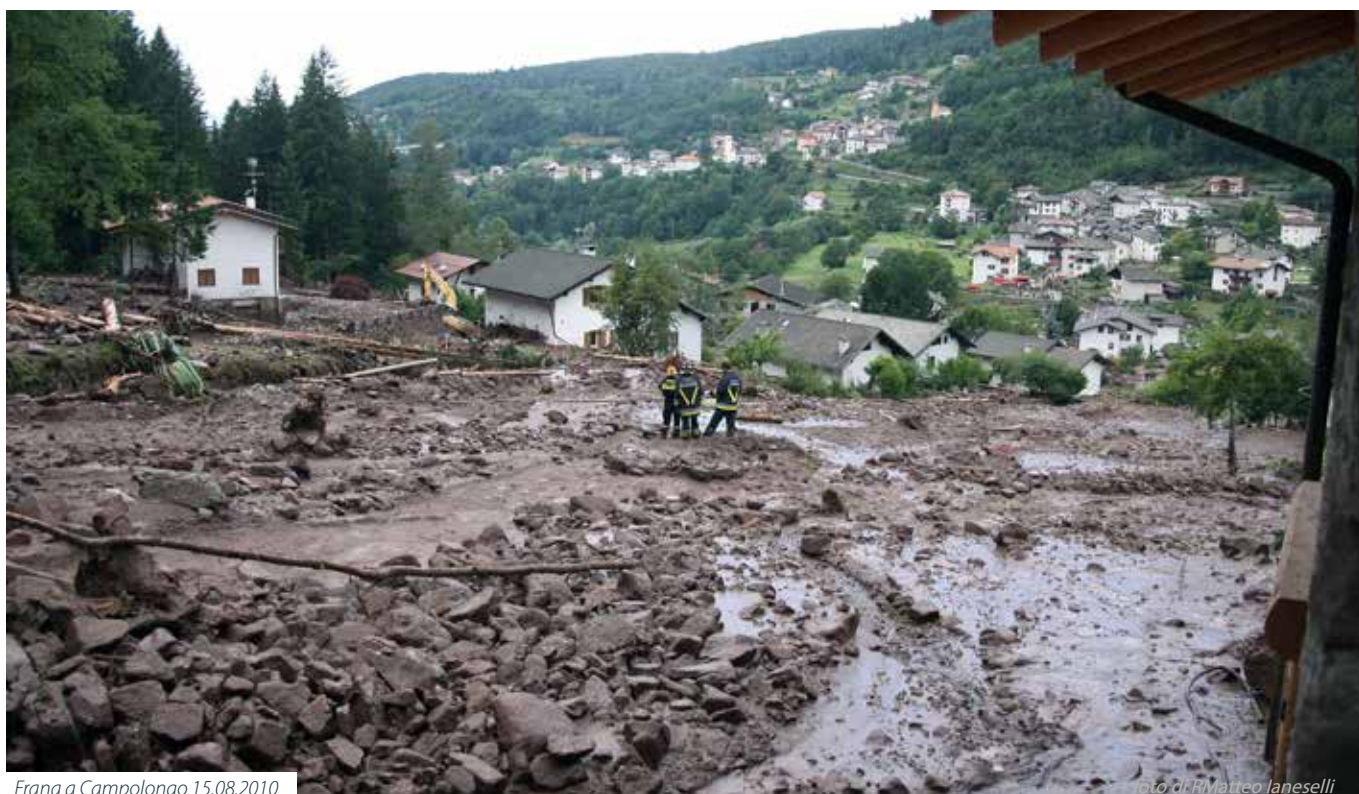
Frana a Campolongo 15.08.2010
