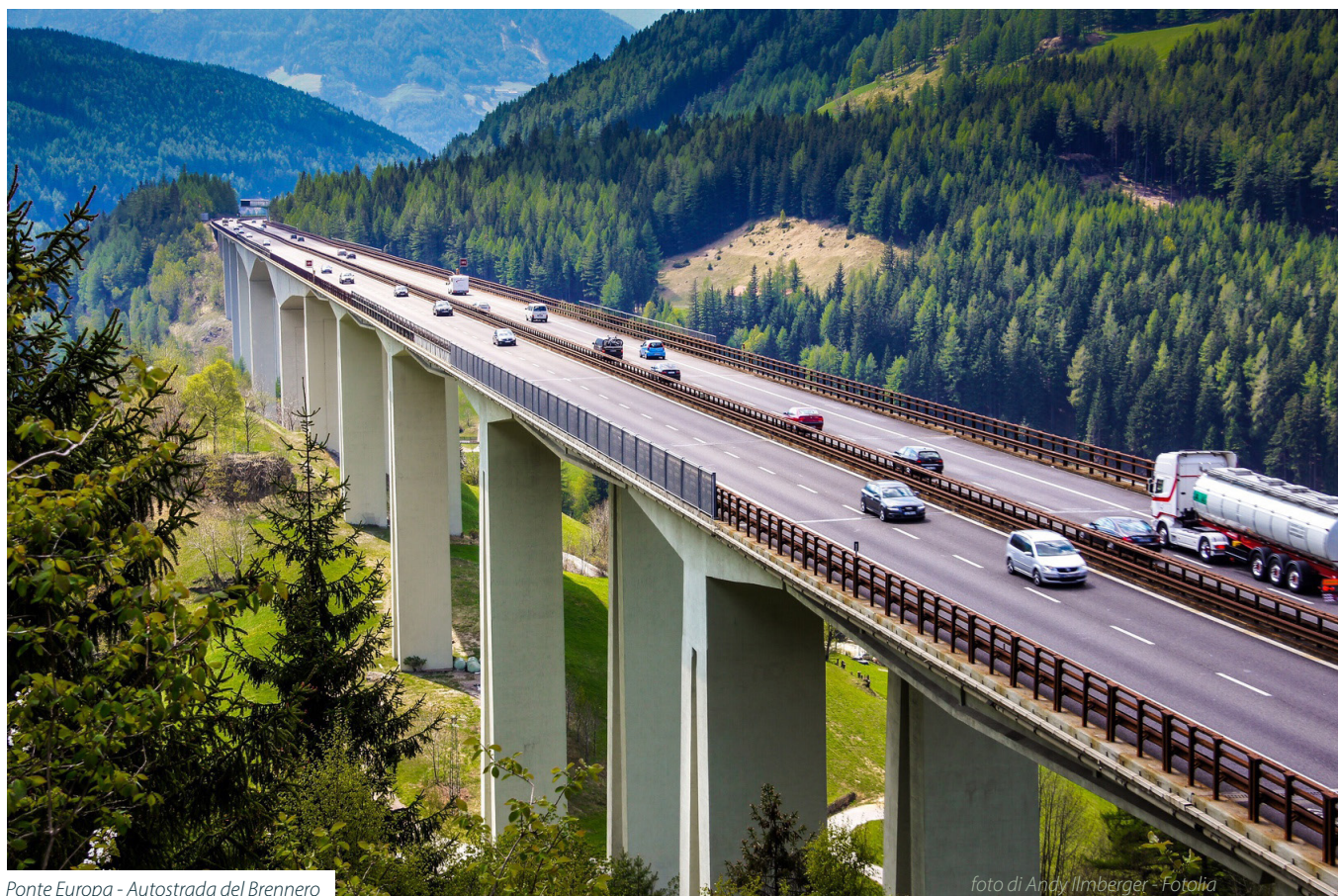
Ponte Europa - Autostrada del Brennero
