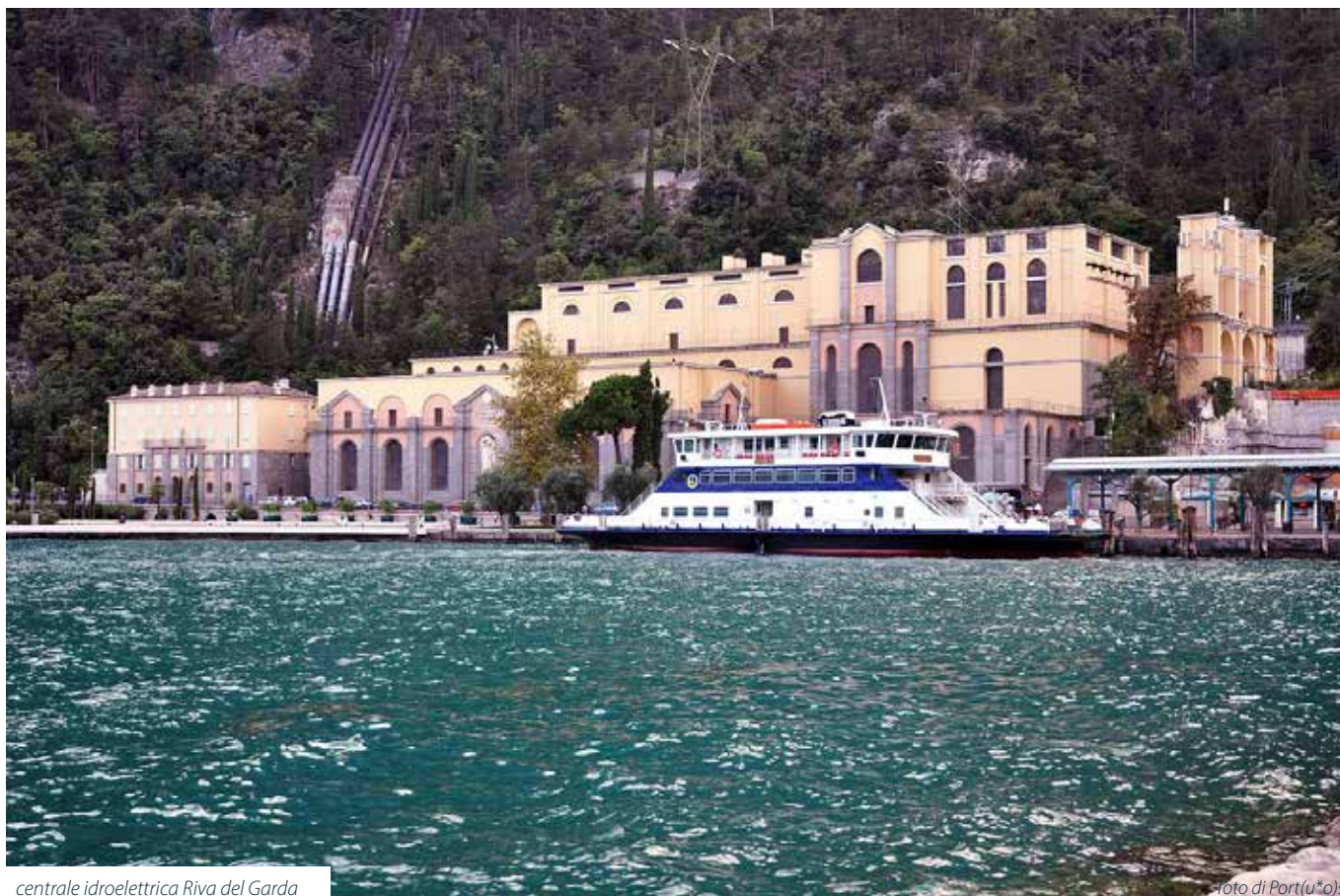
centrale idroelettrica Riva del Garda
