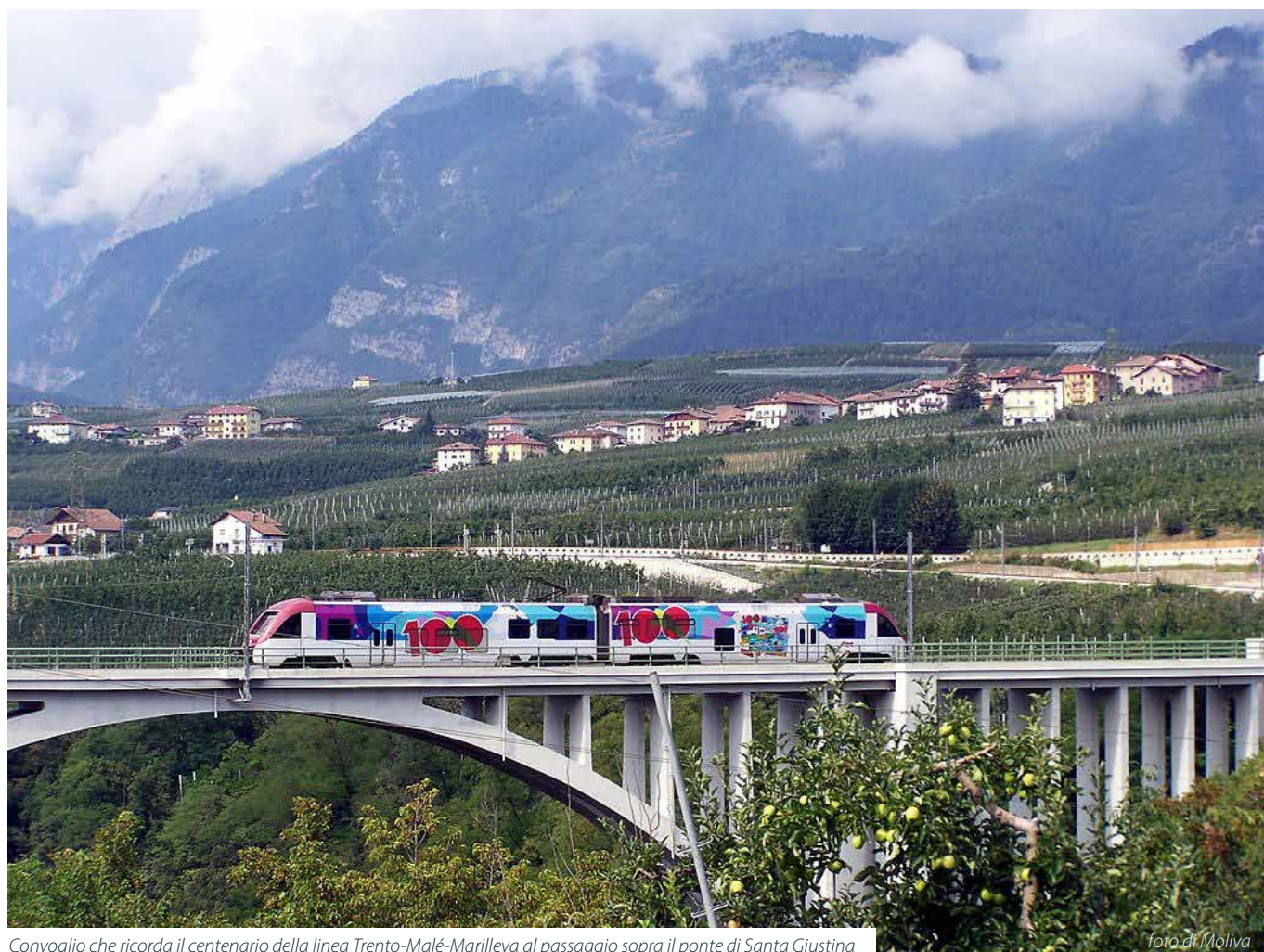
Convoglio che ricorda il centenario della linea Trento-Malè-Marilleva al passaggio sopra il ponte di Santa Giustina
