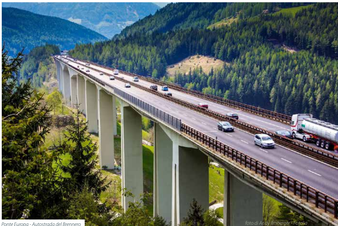
Ponte Europa - Autostrada del Brennero
